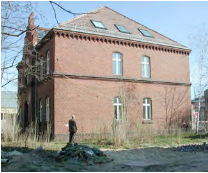
Bundesstiftung Baukultur in Potsdam Bestehendes Haus vor dem Umbau (2008)
