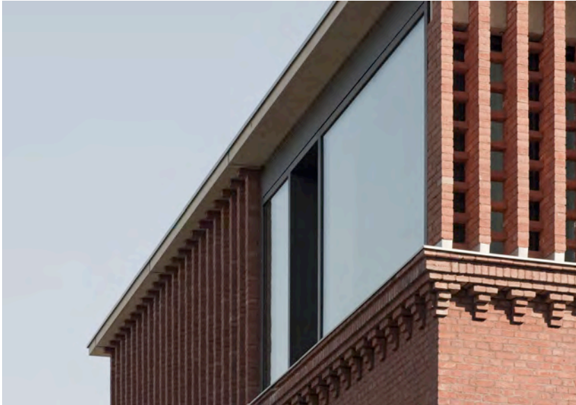
Bundesstiftung Baukultur in Potsdam Detail der Aufstockung
