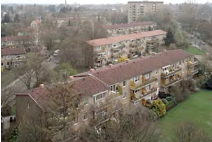
Hamburg, Siedlung Altenhagener Weg Zustand vor dem Umbau
